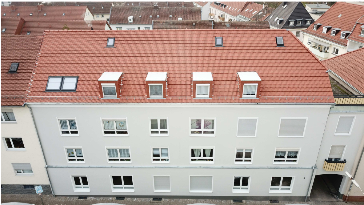
Usenerstr. 4 nach dem Umbau der Gewerbeeinheit im Erdgeschoss zu drei Wohnungen und der Sanierung des gesamten Gebäudes
