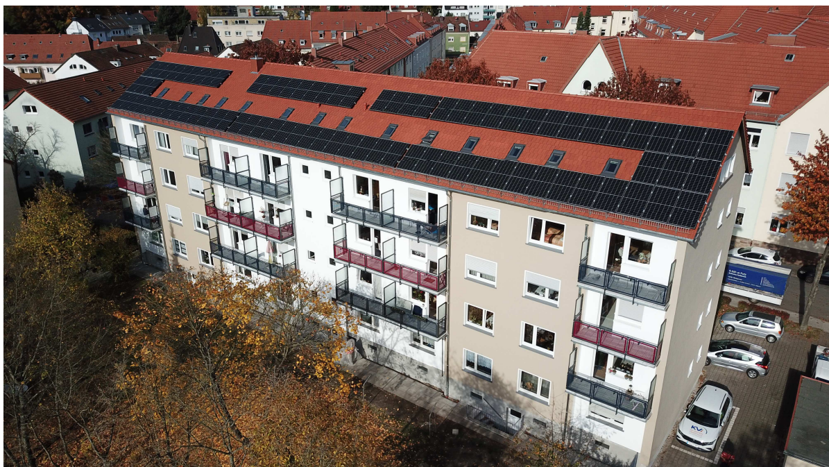
Offenbergstr. 6, 8, 10 nach der Sanierung; die PV-Anlage auf dem Dach erzeugt „grünen“ Mieterstrom
