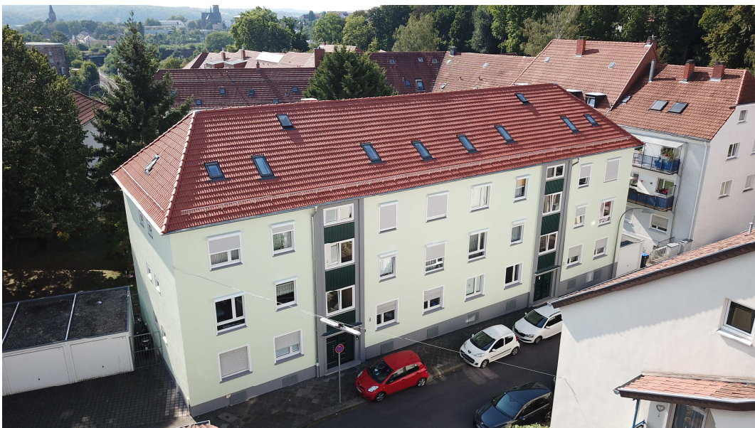
Wolfshumes 2 und 4 mit neuer Dacheindeckung und neuem Anstrich
