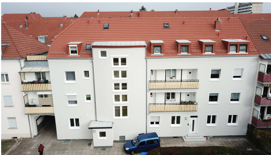
Usenerstr. 4 nach dem Umbau des Erdgeschosses von Gewerbe- zu Wohnraum und der Sanierung des gesamten Gebäudes
